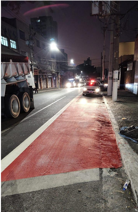
M4 Projeto Cicloviário de São Paulo 21.06.2024 06:06 -23.50573, -46.60431 (±6m) R. Maria Cândida, 1120 - Vila Guilherme - SP, 02071-002
